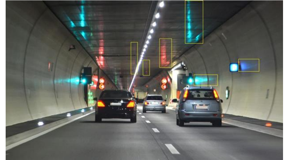
Informationsverarbeitung im Tunnel
